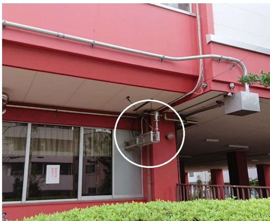
写真 1 採気口の設置位置(○内)と周辺状況
