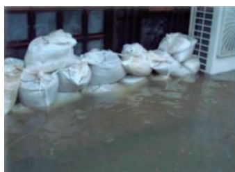
化学物質の浸水防止対策 (土のうの設置)
