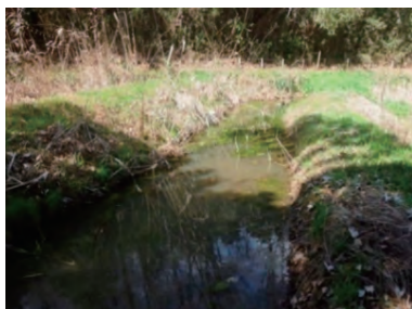
都立公園における ため池の整備
