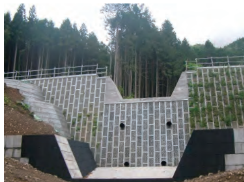
砂防施設整備
