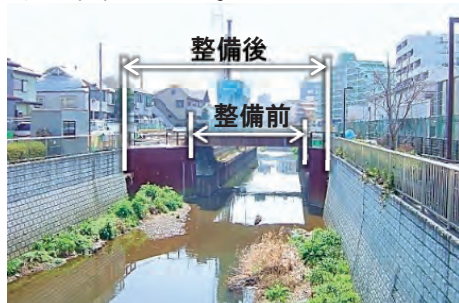
護岸整備（石神井川）
