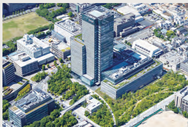
市谷の杜整備後
