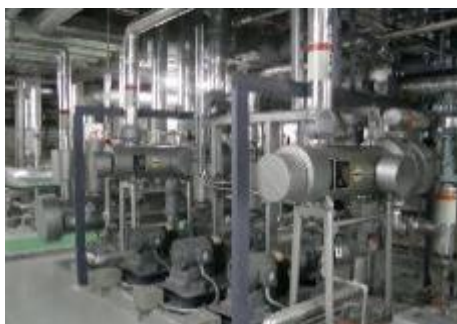
【蒸気配管廻りの保温】
