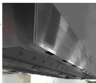
厨房用給排気型フード設置例とイメージ
