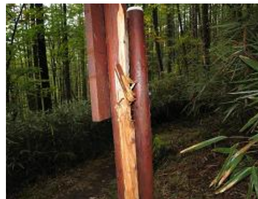
支柱を壊された案内板
