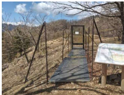
自然環境被害を防ぐ対策 (五十人平野営場 植生保護柵)
