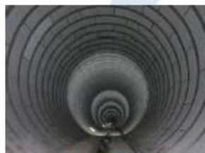
神田川・環状七号線地下調節池
