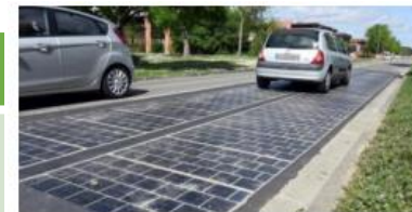
舗装式太陽光パネル
