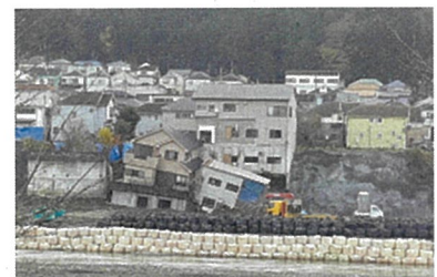
あきる野市被災状況
