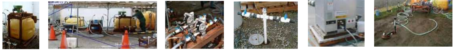
触媒調合タンク プラント全景 ダイアフラム式ポンプ 注入井戸口元 浄化剤貯留タンク 施工状況
