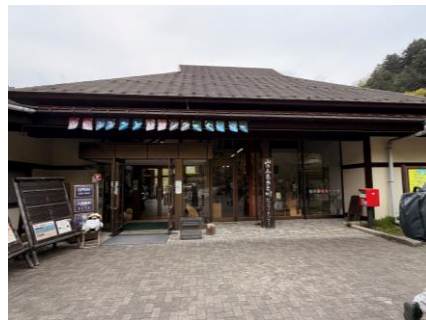
建築から年数の経過したビジターセンター（山のふるさと村）
