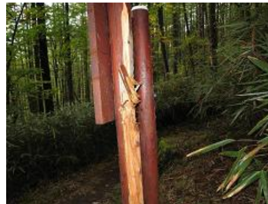
支柱を壊された案内板
