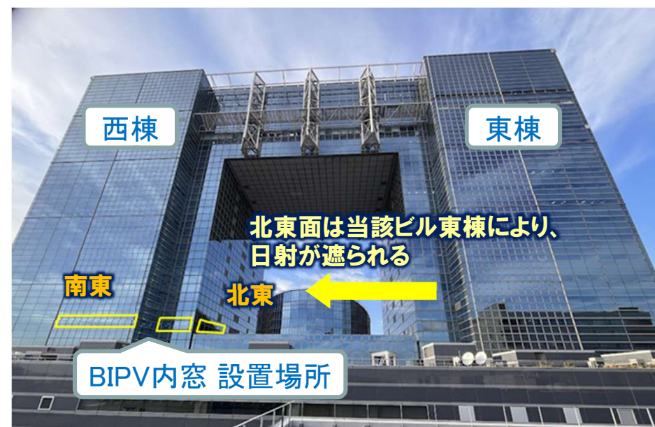
写真④ テレコムセンタービル BIPV内窓 設置場所
