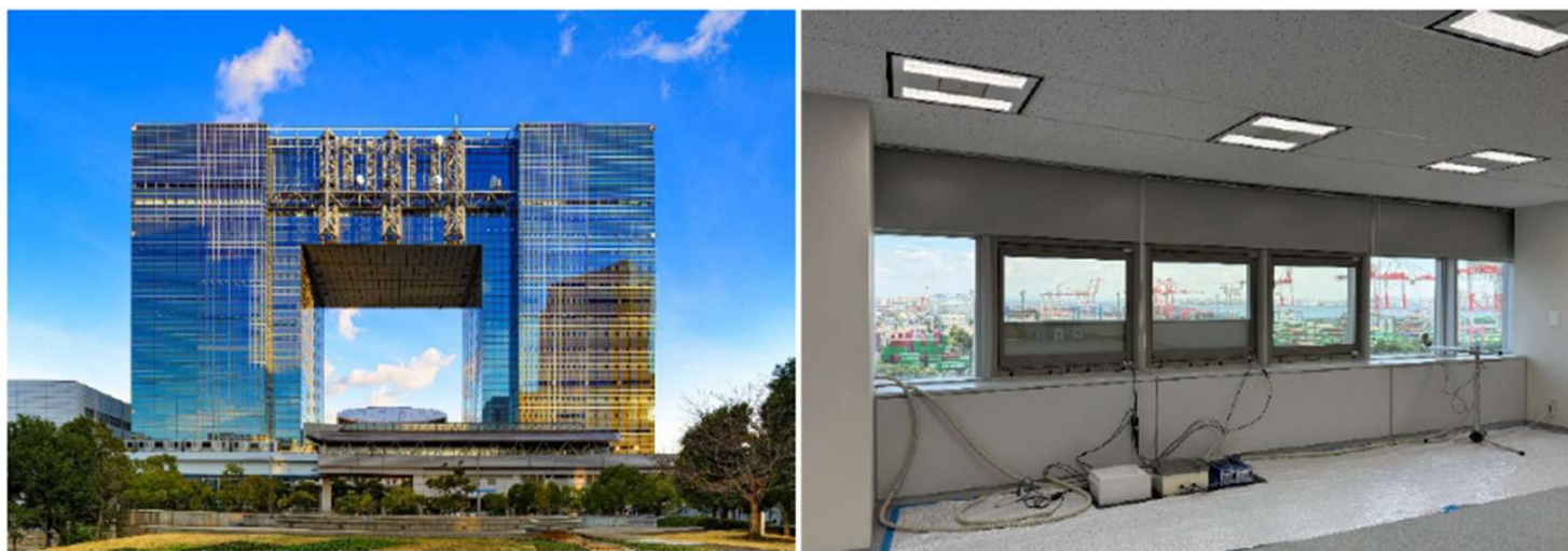
写真② 左: テレコムセンタービル、右: 室内のBIPV内窓設置状況（2025年8月5日 YKK AP ニュースリリースより抜粋）
