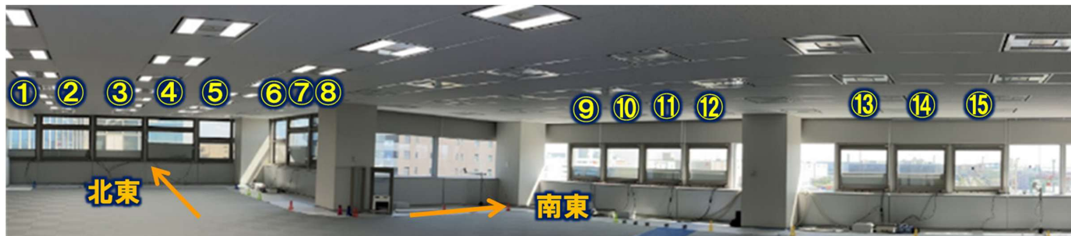
写真① 室内のBIPV内窓設置状況（実証実験中に撮影） 写真の数字①～⑮は、内窓設置箇所
