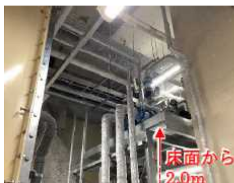
受変電設備を屋上に設置した例、受水設備のかさ上げの例 (画像出典：建築物における電気設備の浸水対策ガイドライン)
