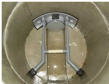
逆流防止弁の設置イメージ、設置例 (上イメージ画像：東京都環境局作成)
