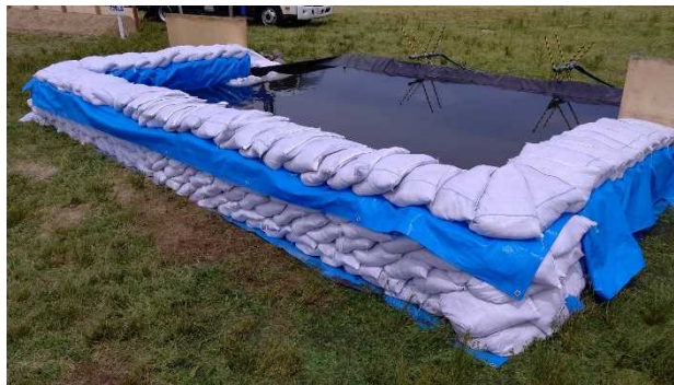
土のうの設置例（ブルーシートで囲む）
