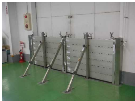
脱着式止水板の場合
