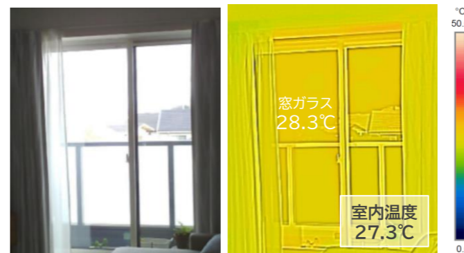
東側外壁及び窓面のサーモ画像(8月下旬15:00)
