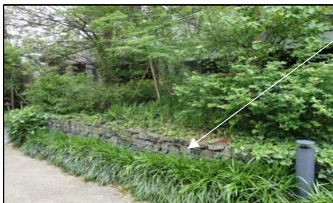
石積み（アークヒルズ 仙石山森タワー）
