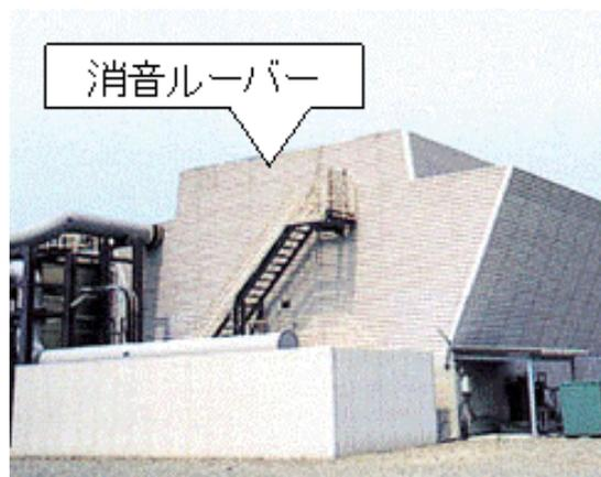
図 2 - 1 3 騒音対策設備の例（冷却塔用消音ルーバー<sup>19)</sup>
