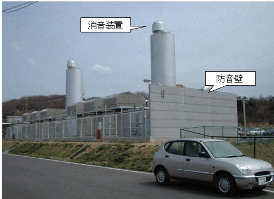
図 2 - 1 2 騒音対策設備の例（吸気ダクト用消音装置、防音壁<sup>18)</sup>
