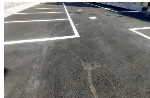
施工後(アスファルト舗装)
