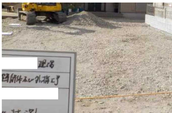
施工前(碎石敷均し)
