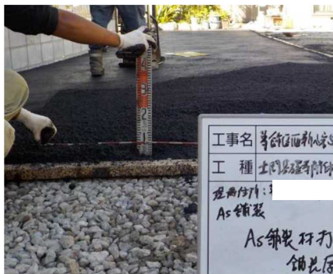
アスファルト舗装5cmで施工
