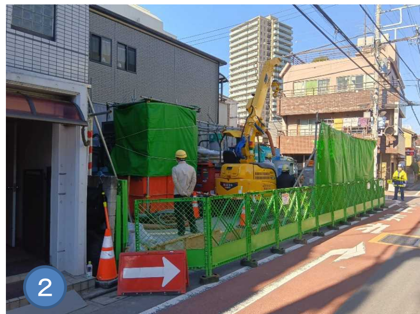
事業場東側道路
