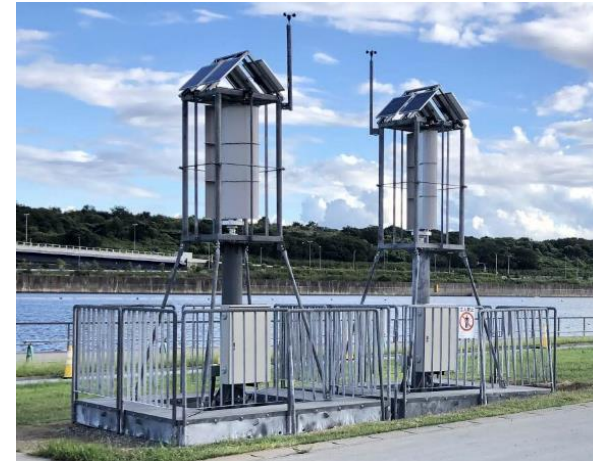
可搬式風力発電設備
