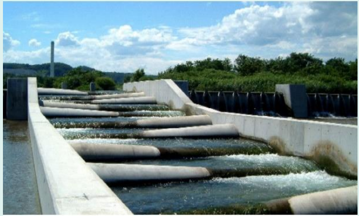
多摩川の日野用水堰に設置された魚道 65
