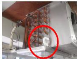
霜の付着（通常冷えるべきでない場所で凍結や結露がある）
