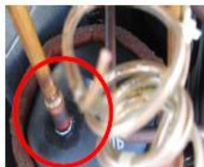
油漏れ（冷凍機油の漏れの痕跡がある又は漏れている）
