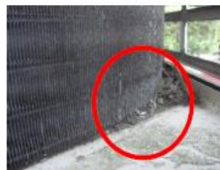
腐食（配管、熱交換にコイル等に腐食等の劣化による穴あきがある）
