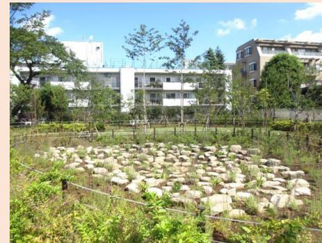
周囲に降った雨水を集めて地下に浸透させる
