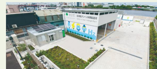
＜東京都京浜島グリーン水素 製造所（大田区京浜島）＞
