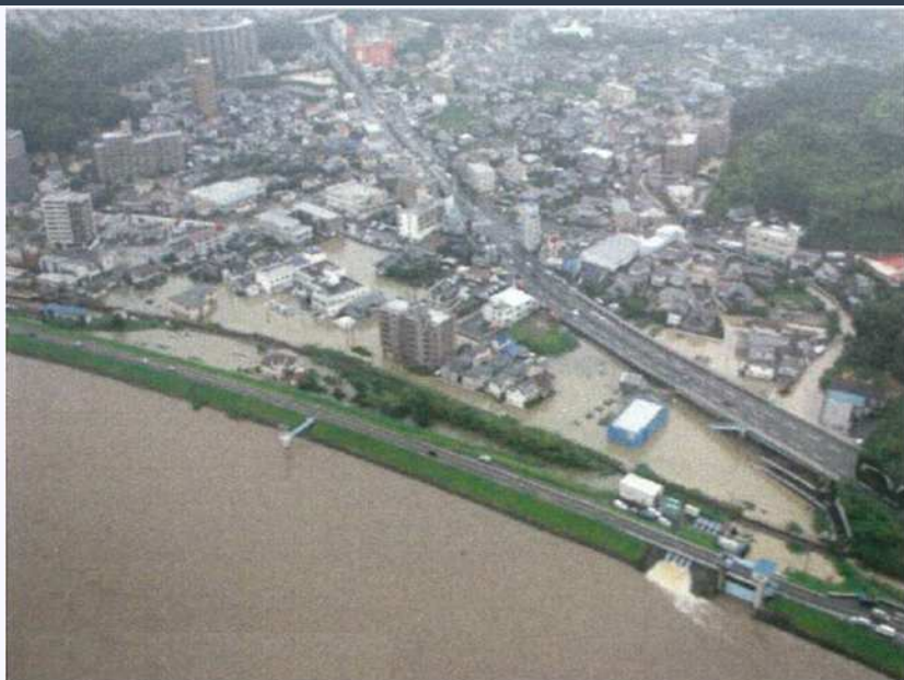
写真 平成22年7月洪水による浸水状況
