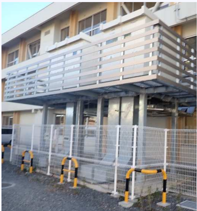
キュービクルの嵩上げ (郡山市内)
