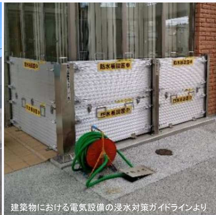
止水板の設置 (常総市役所)
