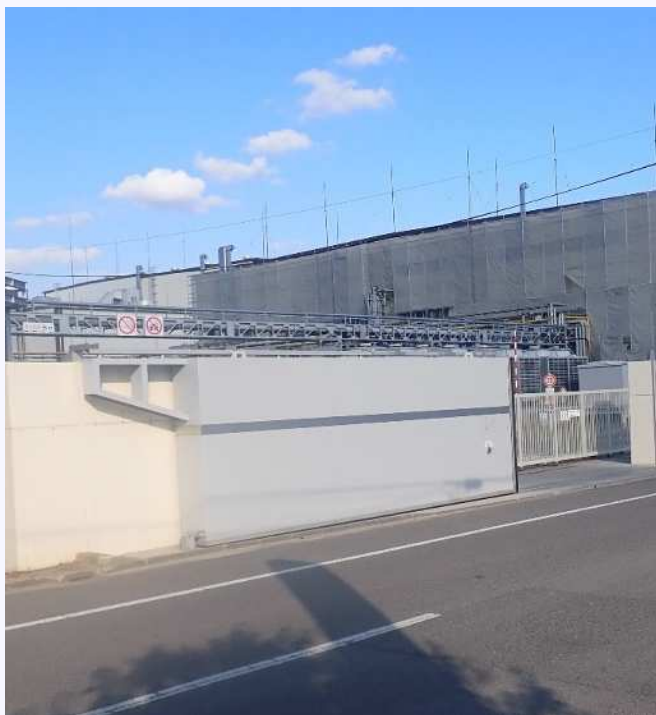
敷地周囲への止水壁 (郡山市内)
