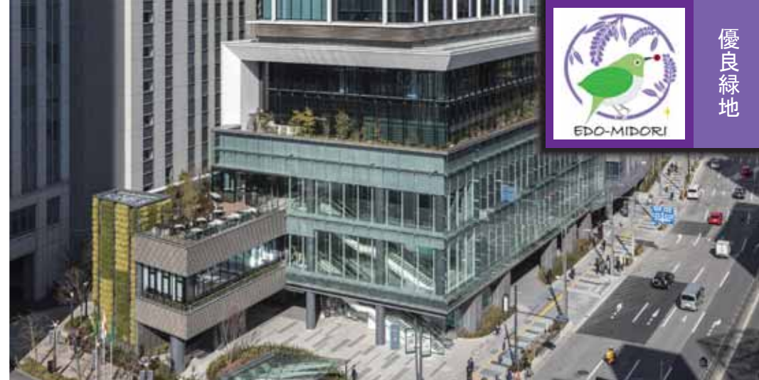
▲鉄鋼ビルディング南館 (外堀通りから撮影)
