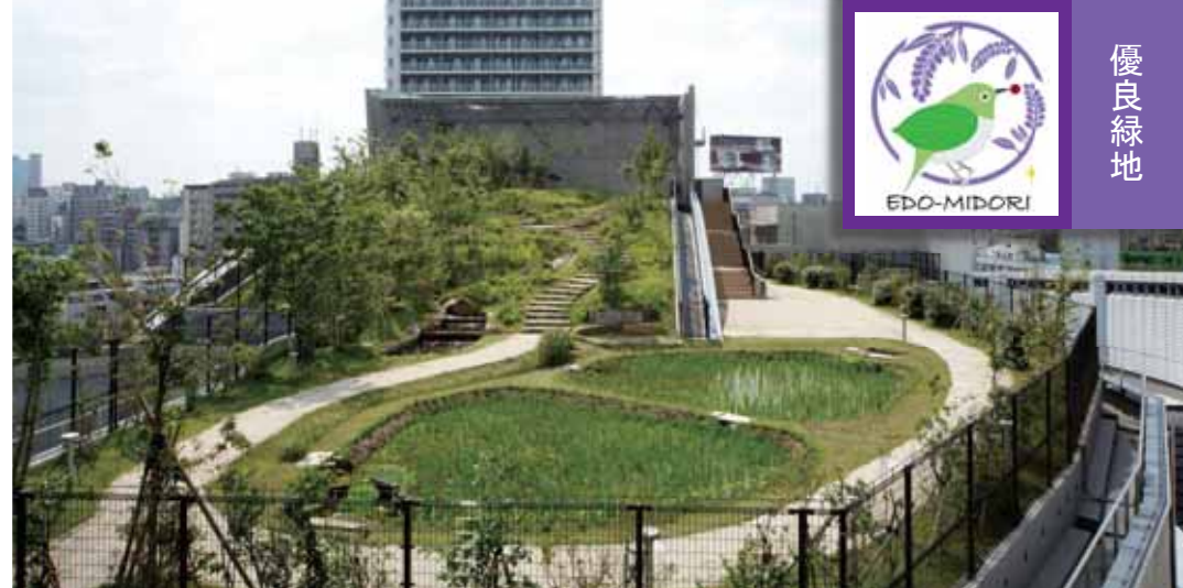
▲大橋換気所屋上の自然再生緑地
