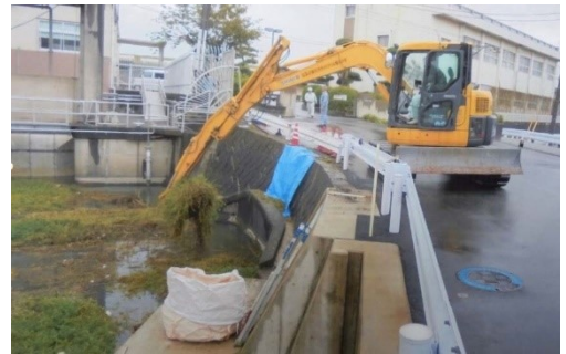
重機による除去
