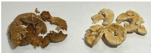
左：腐朽部の木くず 右：正常な心材の木くず
