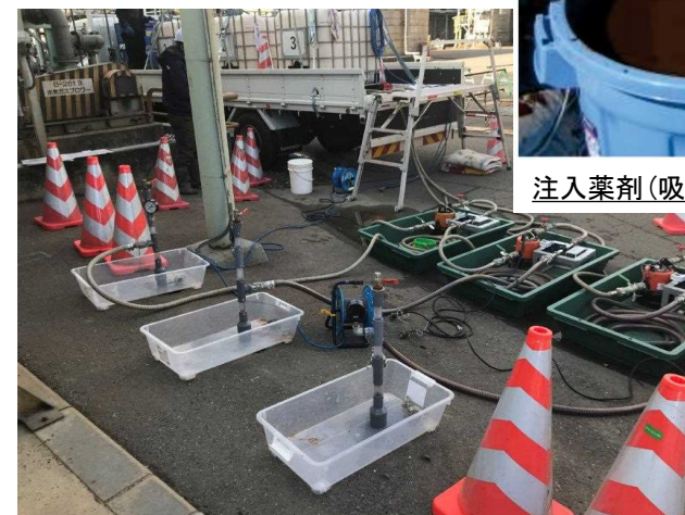
施工状況 (薬剂注入)
