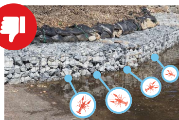
蛇籠を用いた施工
