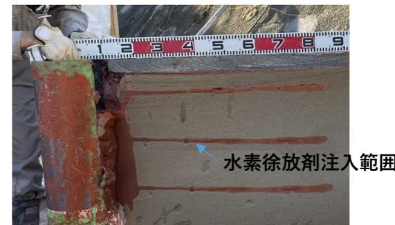
深さ方向に一定間隔でスリット状に切削・注入するため、地盤を泥濁化させない（着色水素徐放剤の地盤鉛直切り出し状況）
