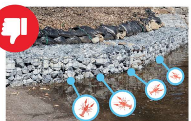
蛇籠を用いた施工
