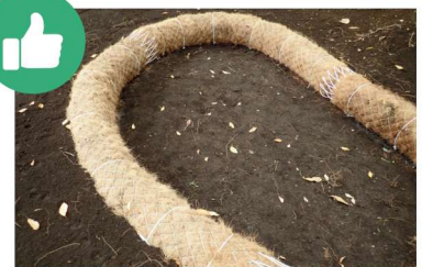
ヤシロールマットを用いた施工
