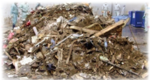
解体現場の混合廃棄物
