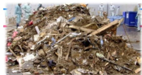
解体現場の混合廃棄物
