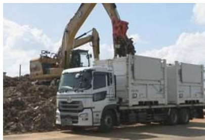
< 災害廃棄物の積込み >
