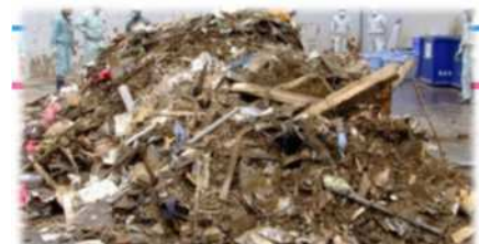
解体現場 of 混合廃棄物
