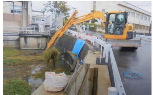
重機による除去
