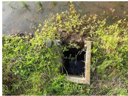
給水栓付近に定着(*2)
