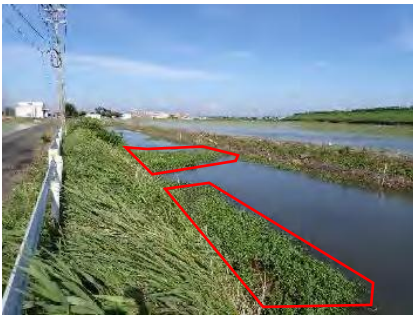
農業用水路で繁茂(*1)
