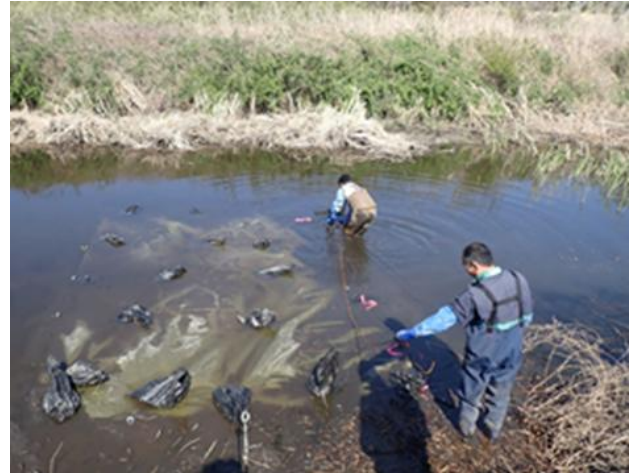
事前に植生を除去した水路底面に敷設
