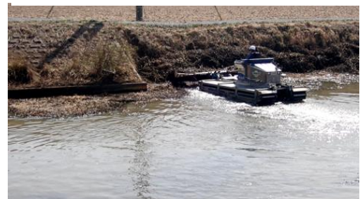
作業船を用いた沖合からの除去 (写真提供：農研機構 額田拓也 氏)
