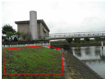
排水機場の法面を覆う(*1)
