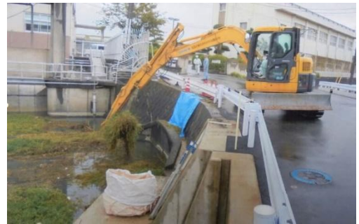
重機による除去
