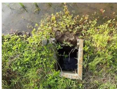
給水栓付近を覆う(*1)
