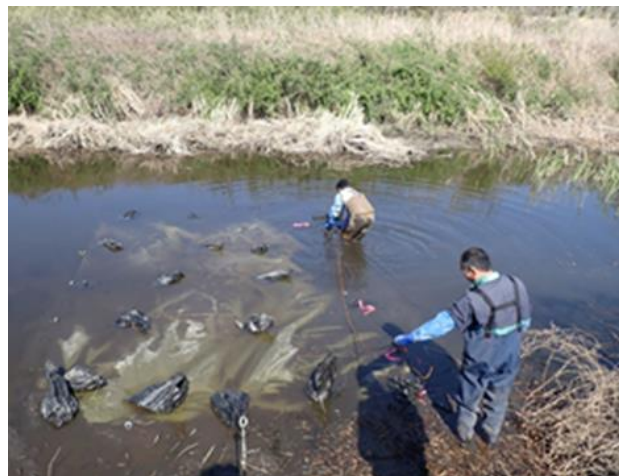
事前に植生を除去した水路底面に敷設
