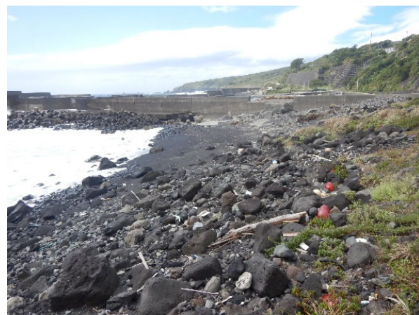
現況写真（右方向）
