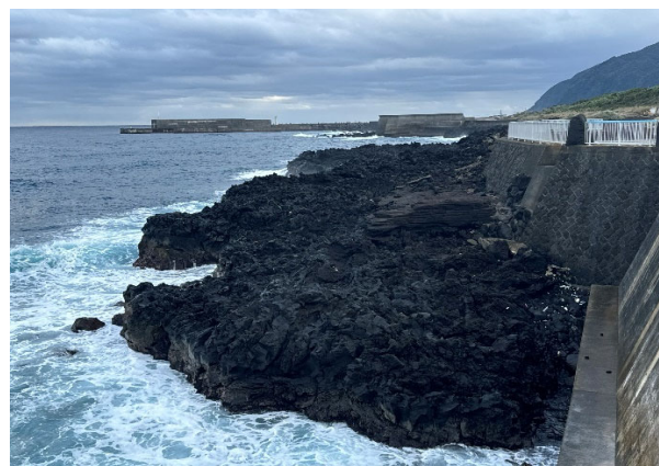
現況写真（右方向）
