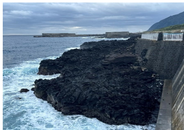
現況写真（右方向）
