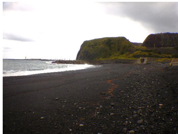
現況写真（右方向）
