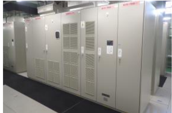
図1 送水ポンプ用インバータ装置
