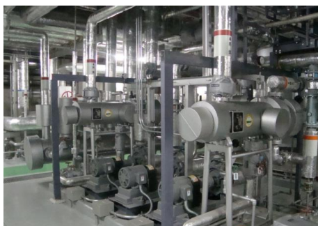
【蒸気配管廻りの保温】
