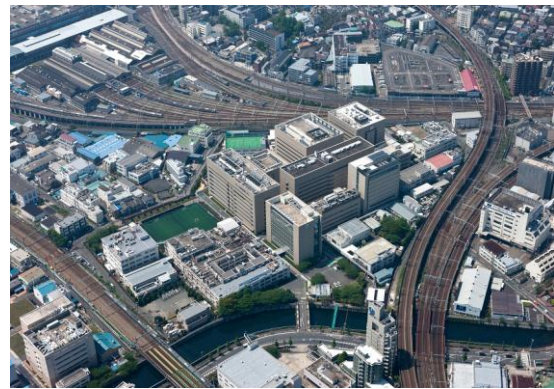
コージェネレーションシステム
