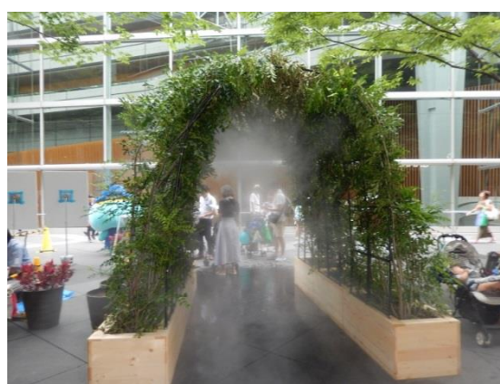
外部給電したドライミスト
