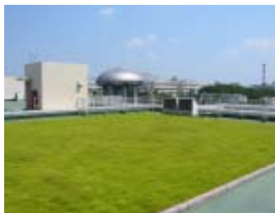
東村山浄水場薬品管理棟屋上
