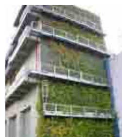
壁面緑化事例
