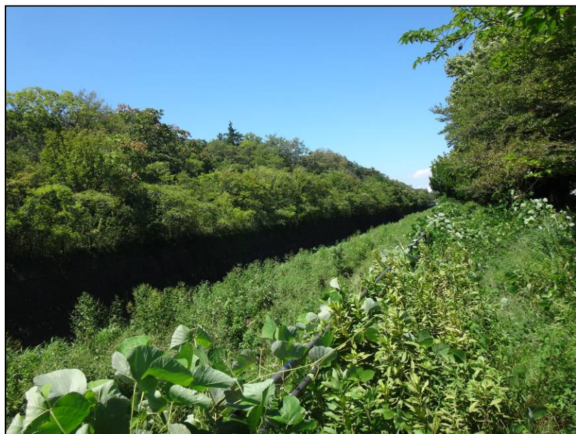
[工事の完了後]
