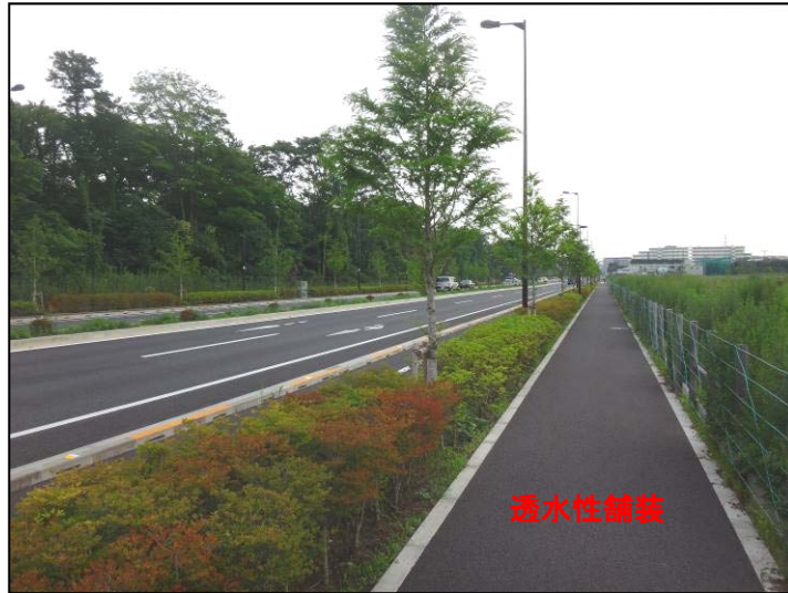
写真 6-2 歩道部の透水性舗装
