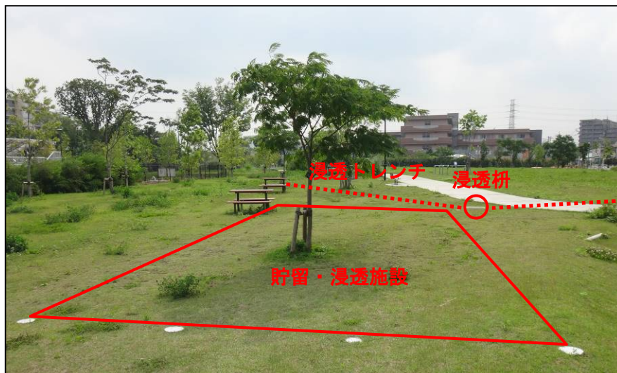
写真 6-1 雨水浸透施設
