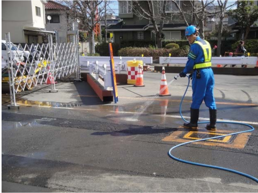
写真 6-2 散水による粉じん発生防止
