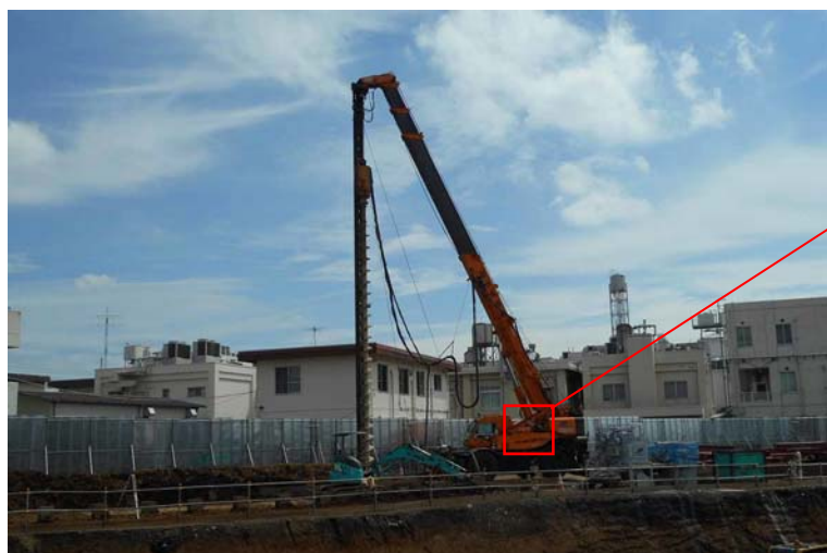
写真 6-1 (2) 排出ガス対策型建設機械の使用状況 (杭打機)
