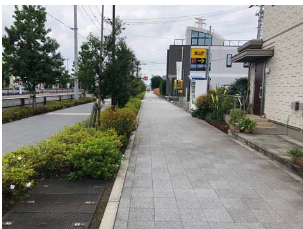
写真 4-1 歩道部におけるインターロッキングブロックの舗装状況
