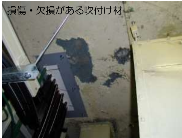
劣化した吹付け材の例
