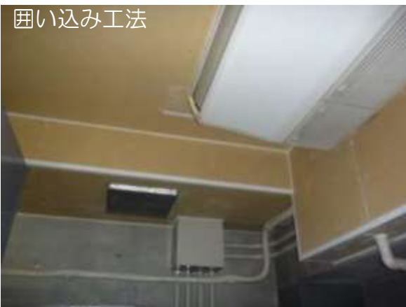
封じ込め工法、囲い込み工法の施工例
