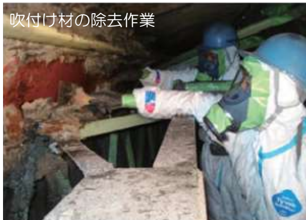
除去工法の施工例
