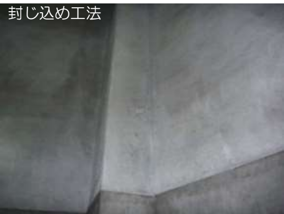
封じ込め工法、囲い込み工法の施工例
